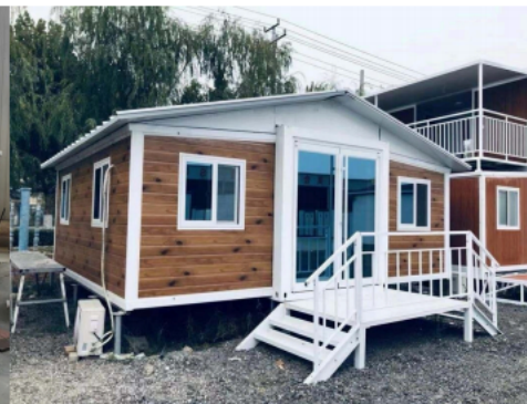
Telhado de duas inclinações
